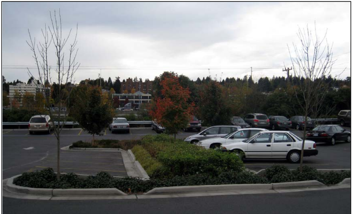
Kuva 7. Esimerkkikuvat paikoitusalueen biopidätysrakenteesta.
